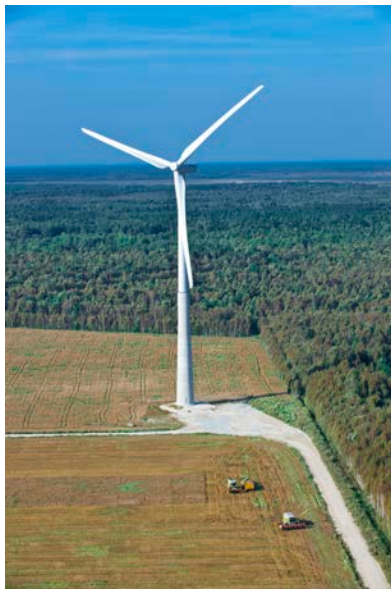
Kuva 2. Kuva 3 MW tuulivoimalasta, jonka tornin alaosa on betonia ja yläosa terästä sekä periaatekuva tuulivoimalasta (Lähteet: WinWind Oy, planete-energies.com)
