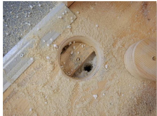
Kuvat 26 ja 27. Puutyöluokan lattiassa puukoolaus ja lattialauditus, koolausvälissä EPS-eristys.
