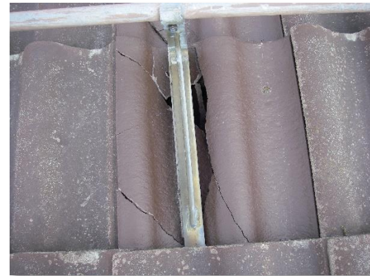
Kuvat 106 ja 107. Rakennuksen tiilikatteesta havaittiin paikallinen vaurio.
