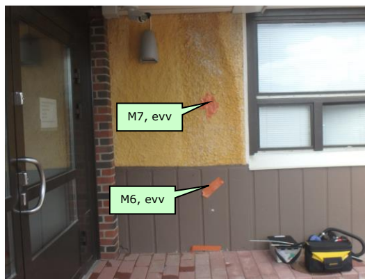
Kuva 43. Luokan A104 ulkopuoliset rakenneavauskohdat.
