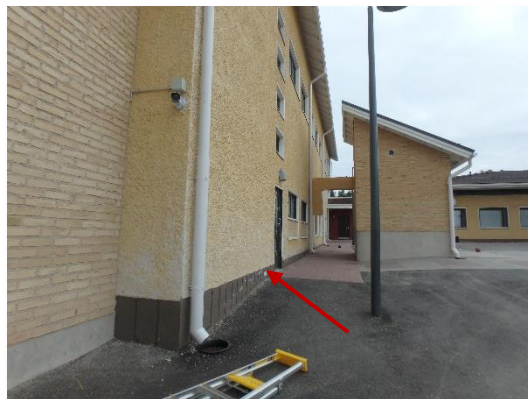
Kuvat 49 ja 50. Porrashuoneen A041 sokkelin yläosaan rakennusaukko.
