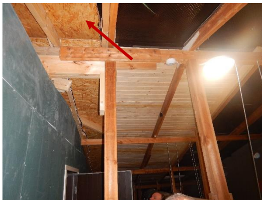
Kuva 112. IV-konehuoneen laajennuksen kohdalla katossa OSB-levytys.
