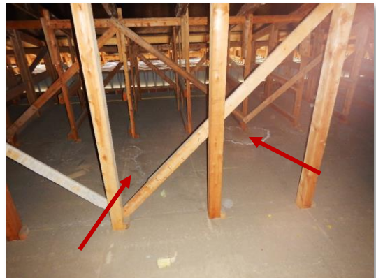
Kuvat 114 ja 115. Kattoristikoissa ja yläpohjaeristeiden pinnalla useita kosteusjälkiä.
