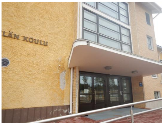
Kuvat 41 ja 42. Ulkoseinissä paikallisia vaurioita ja rappauspinnan kulumista sekä paikkausjälkiä.
