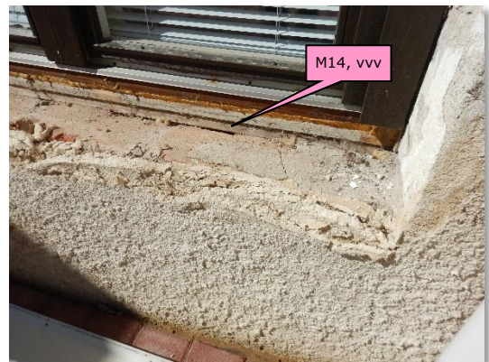
Kuvat 30 ja 31. Puutyöluokan ikkunaliittymän alapuolinen ulkoseinäeriste ja täytemateriaali on mikrobivaurioitunut.
