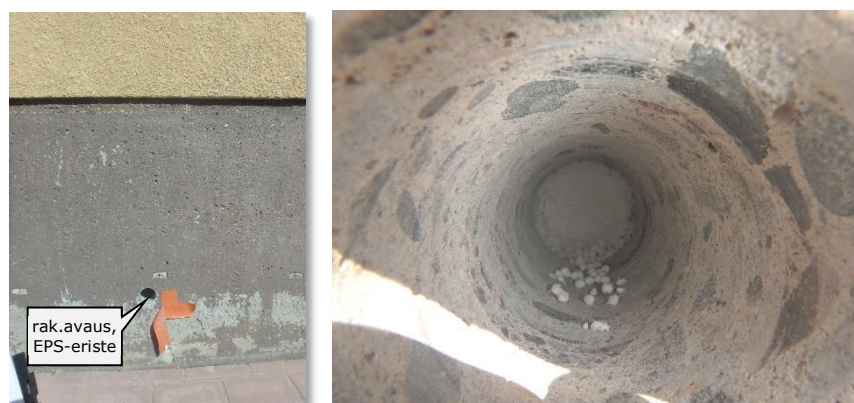
Kuvat 96 ja 97. Sokkelihalkaisussa EPS-eriste.
