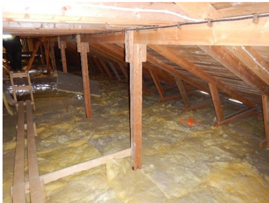
Kuva 73. Vanhan osan liikuntasalisiiven yläpuolinen välikattotila, yleiskuva.
