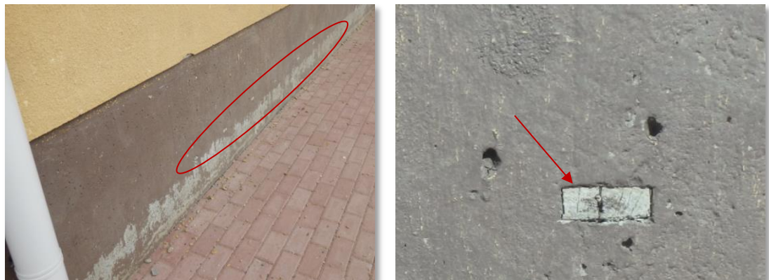
Kuvat 94 ja 95. Sokkelissa paikoilleen jätettyjä surritappeja.
