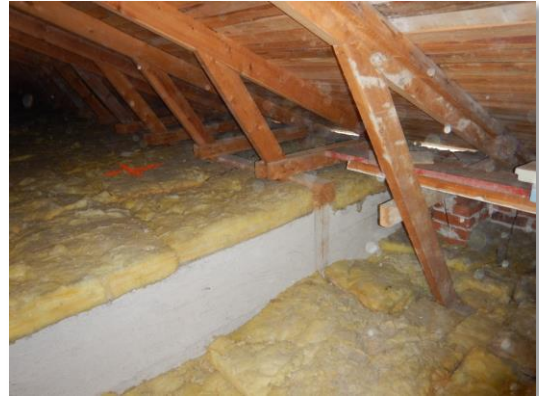
Kuva 72. Luokkahuoneiden sisäkatto on hieman ympäröiviä tiloja korkeammalla.
