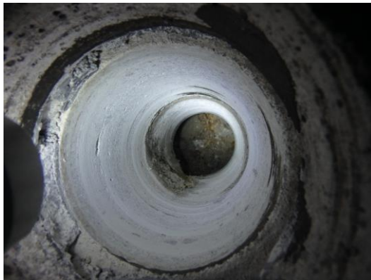
Kuva 7. Kellarin alapohjan rakenne- avaus.
