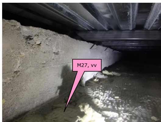
Kuvat 63 ja 64. Liikuntasalin välinevaraston lattian rakennearaus, alalaattapalkiston palkkiväleissä uuden mineraalivillaeristys alla vanhan purueristeiden jäämiä.
