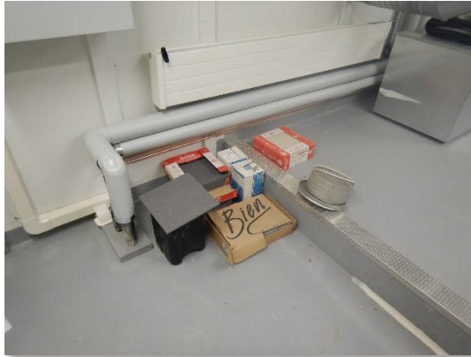
Kuva 104. Ilmanvaihtokonehuoneen alkuperäisen ja laajennusosan liittymä.
