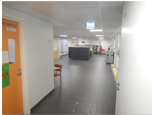
Kuva 99. Laajennusosan lattia-päälysteeksi asennettu laatoitus.
