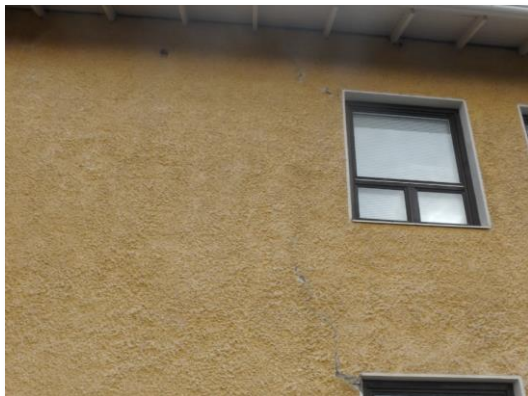
Kuvat 39 ja 40. Ulkoseinissä paikallisia halkeamia ja valumajälkiä.
