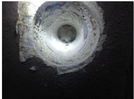
Kuvat 47 ja 48. Ruokalan sokkelin alaosaan rakennusaukko.
