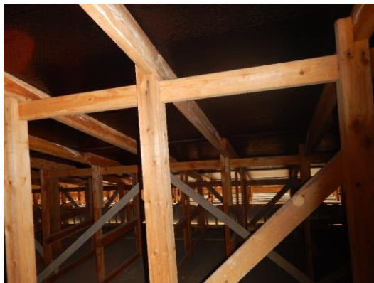
Kuvat 114 ja 115. Kattoristikoissa ja yläpohjaeristeiden pinnalla useita kosteusjälkiä.
