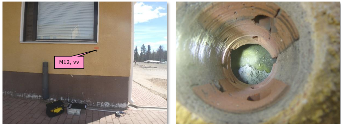
Kuvat 92 ja 93. Luokan B168 ulkoseinän rakenneavaus.
