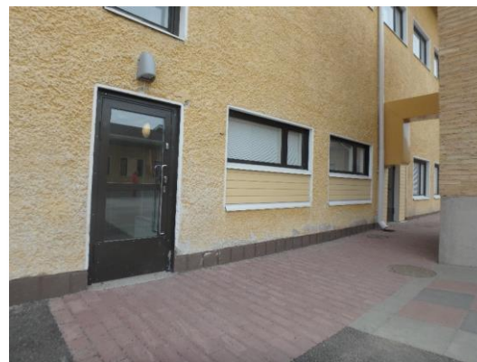
Kuvat 41 ja 42. Ulkoseinissä paikallisia vaurioita ja rappauspinnan kulumista sekä paikkausjälkiä.
