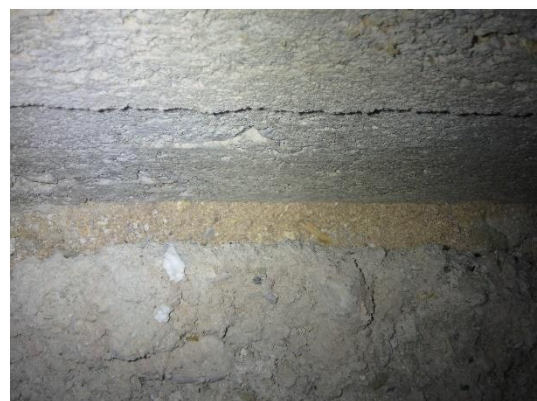
Kuvat 63 ja 64. Liikuntasalin välinevaraston lattian rakennearaus, alalaattapalkiston palkkiväleissä uuden mineraalivillaeristys alla vanhan purueristeiden jäämiä.
