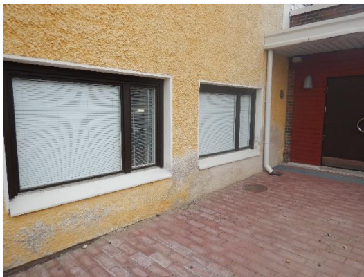
Kuvat 30 ja 31. Puutyöluokan ikkunaliittymän alapuolinen ulkoseinäeriste ja täytemateriaali on mikrobivaurioitunut.
