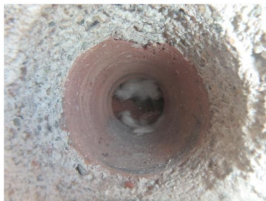
Kuva 44. Luokan A104 ulkoseinän rakenneavaus.
