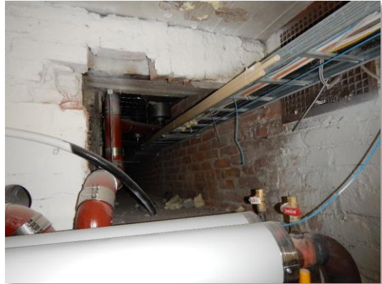
Kuva 12. Kulkuaukko ruokalan alapuoliseen putkikanaaliin.
