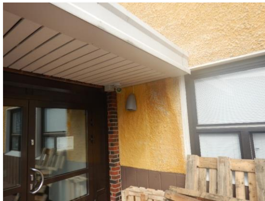
Kuvat 39 ja 40. Ulkoseinissä paikallisia halkeamia ja valumajälkiä.
