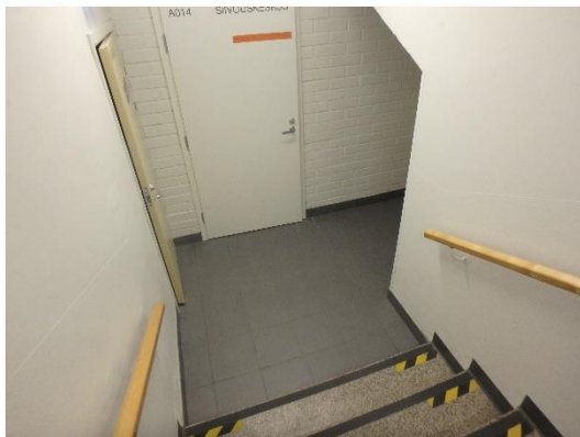
Kuva 13. Kellaritilaan johtava avoin porraskäytävä.
