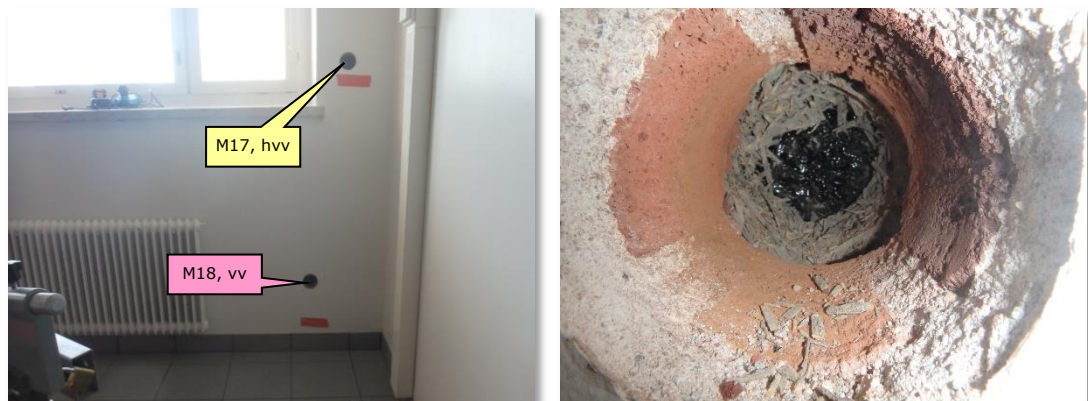
Kuvat 32 ja 33. Teknisen työn tilojen ulkoseinän rakenneavauskohdat, seinässä verhoustiilen takana Toja-eristys.
