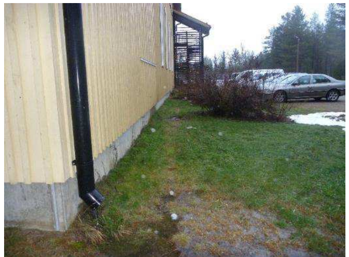
Kuva 87. Sadevedet on ohjattu rakennuksen vierelle.
