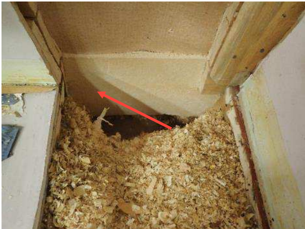
Kuva 13. RA1. Ulkoseinän ja al pohjan liittymän kautta sisäilmaan voi kulkeutua epäpuhdasta ilmaa. Avauksen kohdalla ei havaittu poikkeavaa hajua.
