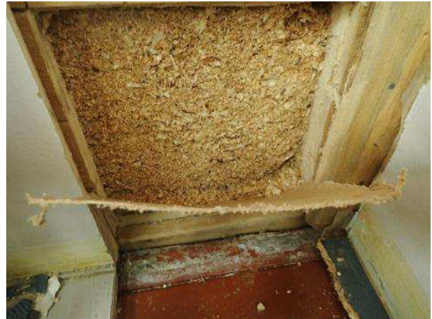
Kuva 37. RA1. Ulkoseinäeristeenä sahanpuru. Rakennneavauksessa ei havaittu poikkeavaa hajua.
