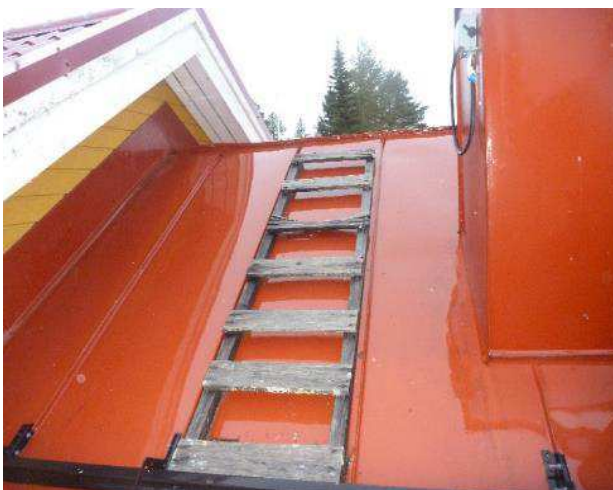
Kuva 97. Lapetikkaat ovat lahonneet.
