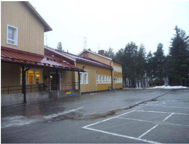
Kuva 4. Kuva rakennuksen etusivulta. Piha-alue on asfalttipintainen ja kallistus on loiva rakennuksesta poispäin.
