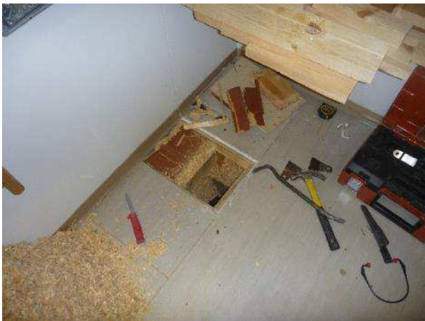
Kuva 19. RA6. Teknisentyönluokan lattiaan tehtiin rakenneavaus ryömintätilan kohdalle. Rakenneavauksessa tunkkainen haju.
