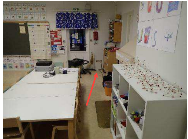
Kuva 45. Rakenneavaus RA8 tehtiin 2. kerroksen tilaan 211, rakennuksen päätyseinälle.
