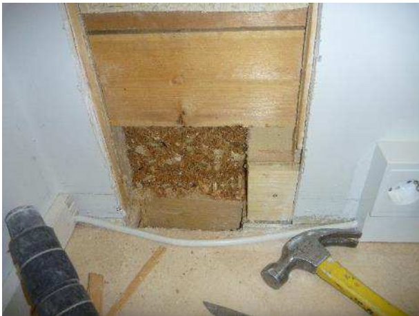
Kuva 44. RA7. Umpilaudoituksen takana puukuitulevy ja eristeenä sahapuru.
