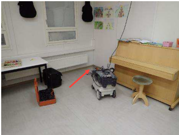
Kuva 34. Rakenneavaus RA1. Tehtiin ulkoseinän ja alapohjan liittymään.
