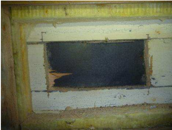
Kuva 56. RA14. Lisälämmöneristyksen takana on alkuperäinen ulkovuoriverhous. Ulkovuorauksen takana on tuulensuojapaperi. Paperi sisältää runsaasti PAH-yhdisteitä.
