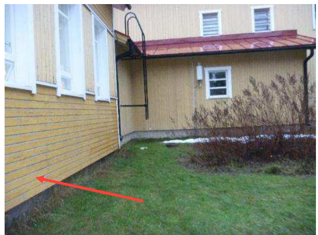
Kuva 55. Rakenneavaus RA14 tehtiin luokkatilan 118 kohdalle.
