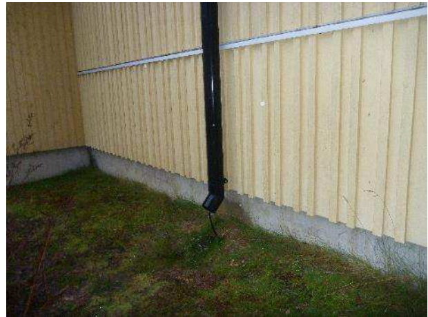
Kuva 89. Alapohjarakenne tarkastettiin ulkoseinäavauksen kohdalta. RA15
