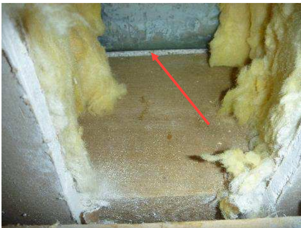
Kuva 90. Alapohjaeristeenä styrox eriste.
