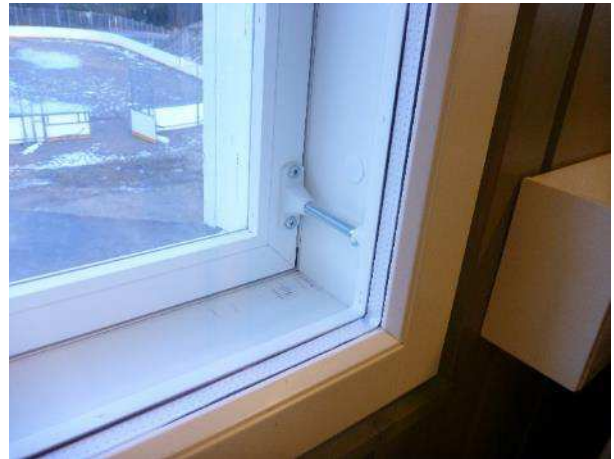
Kuva 94. Kuva laajennuksen ikkunasta. Ikkunat ovat hyväkuntoiset.
