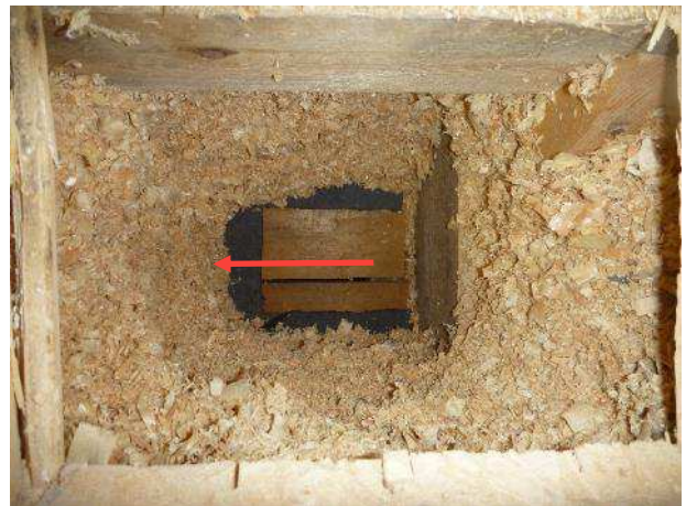
Kuva 20. RA6. Kutterinpurueristeiden alla on tuulensuojapaperi. Ryömintätila ja alapuoliset rakenteet kuvattiin tämän avauksen kautta. Näyte M10 otettiin nuolen kohdalta.
