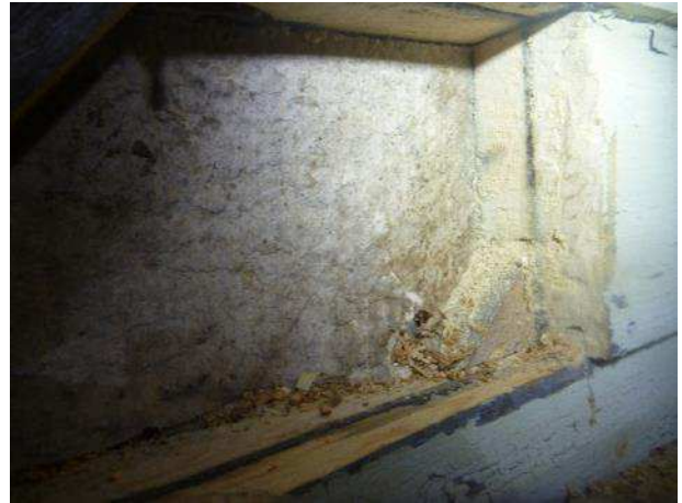
Kuva 57. RA14. Ulkoverhouksen takana umpilaudoitus, kartonki ja ulkoseinärunko.
