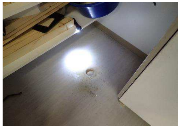
Kuva 16. Rakenneavaus RA5 teknisentyöluokan lattiaan putkikanaalin yläpuolelle.
