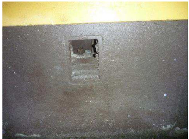
Kuva 26. Rakennuksen sokkelissa on kaksi kappaletta tuuletusaukko ryömintätilaan.
