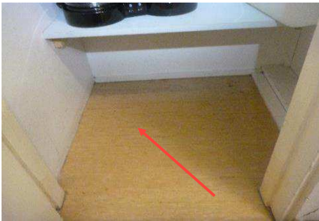
Kuva 61. 1. kerroksen välipohjan rakenneavaus RA4 tehtiin keittiön 131 komeroon.
