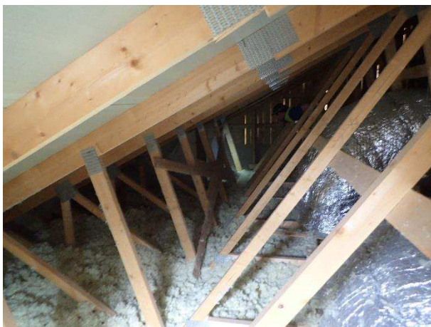
Kuva 103. Yleiskuva yläpohjasta. Kattokannattimet ovat hyväkuntoiset.
