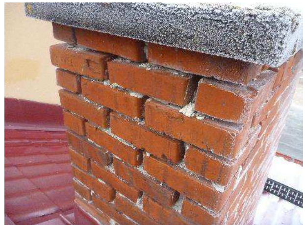
Kuva 70. Tiilen kiinnityslaasti on irronnut ja tiilit ovat osin irti. Muuraus suositellaan korjattavaksi ensitilassa.
