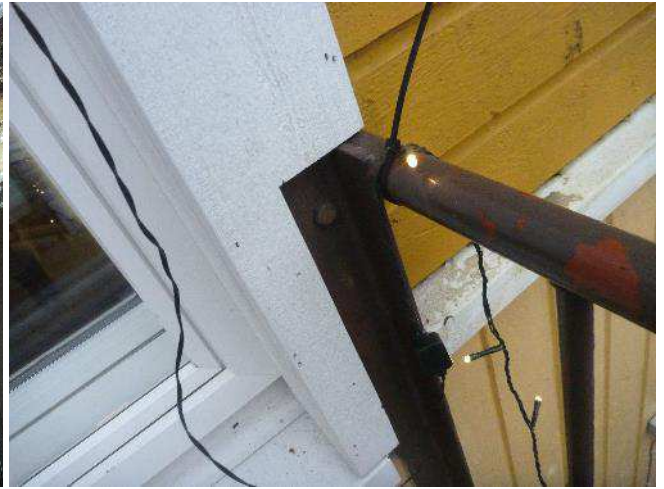
Kuva 83. Parveke on kiinnitetty seinärunkoon kansiruuveilla.
