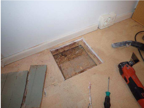
Kuva 116. Välipohjan rakenneavaus toisen kerroksen eteisessä rakennuksen vanhalla osalla.
