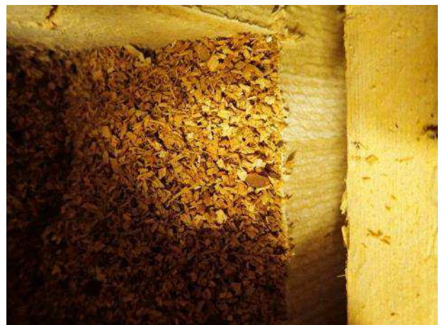
Kuva 47. RA8. Ulkoseinäeristeessä ei havaittu merkkejä vaurioista.
