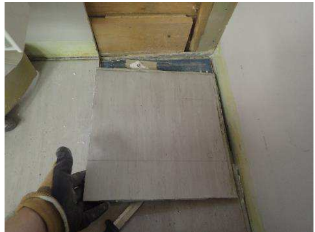
Kuva 10. RA1. Päällimmäisenä lattiakerroksena on muovimatto ja kipsilevy.
