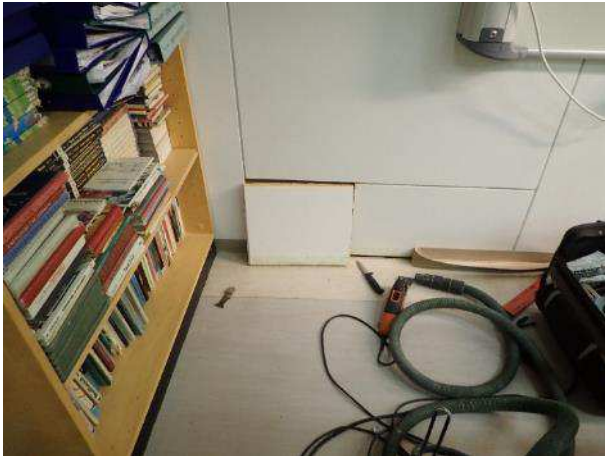
Kuva 38. Rakennneavauksen RA2 kohta, vanhan osan päätyseinä laajennusta vasten. Nykyinen väliseinä.
