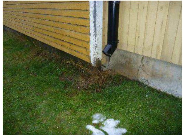
Kuva 53. RA13. Rakenneavauksen kohdalla syöksyputki.
