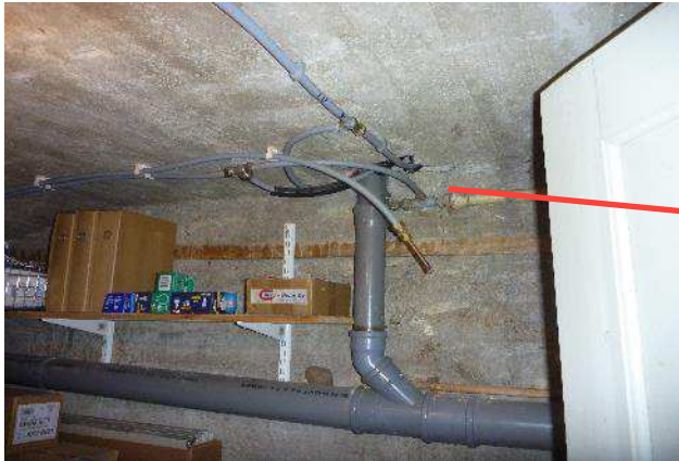
Kuva 63. Läpivienti kellarista välipohjan läpi 1. kerrokseen.
