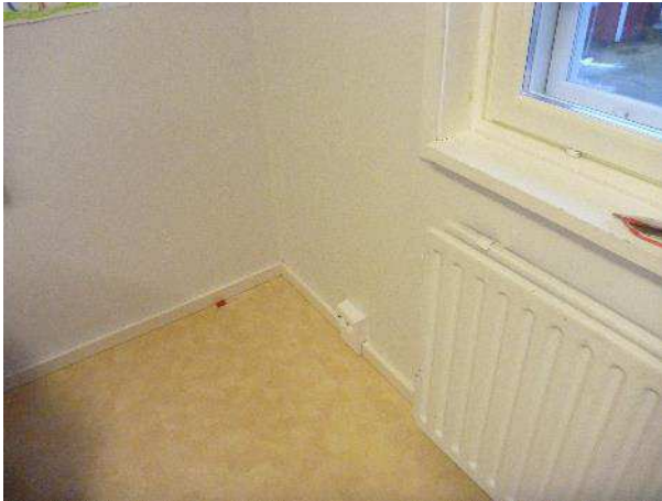
Kuva 65. 2. kerroksen välipohjan rakenneavaus RA7 tehtiin ulkoseinän liittymään.
