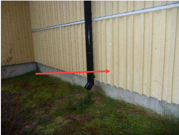
Kuva 91. Rakenneavauksen RA15 kohta liikuntasalin kohdalla.
