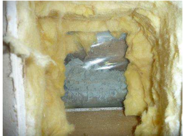
Kuva 92. RA15. Mineraalivillassa ei havaittu vaurioita.
