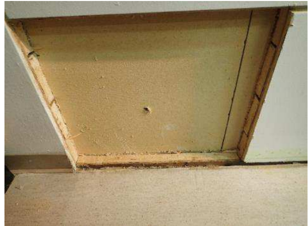
Kuva 39. RA2. Alkuperäinen umpilaudoitus ja puukuitulevy on paikoillaan.
