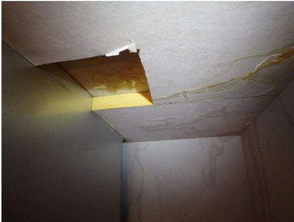
Kuva 113. IVK-huoneessa tehtiin rakenneavaus kattoon hormin viereen.
