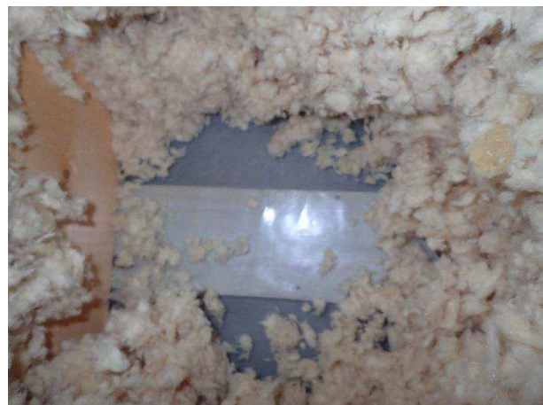
Kuva 110. Yläpohjan eristevahvuus ~300 mm ja sen alla höyrynsulkumuovi ja harvalaudoitus.
