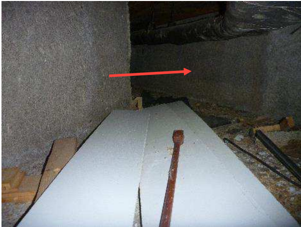
Kuva 52. Rakenneavaus RA13 putkikanaalin ulkoseinässä.
