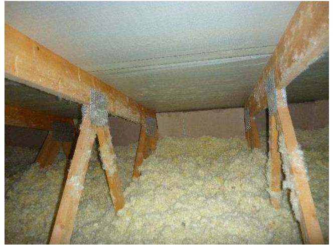
Kuva 100. Kuva yläpohjasta räystääsalueelta. Räystäät ovat umpinaiset eikä yläpohja tuuletetu.
